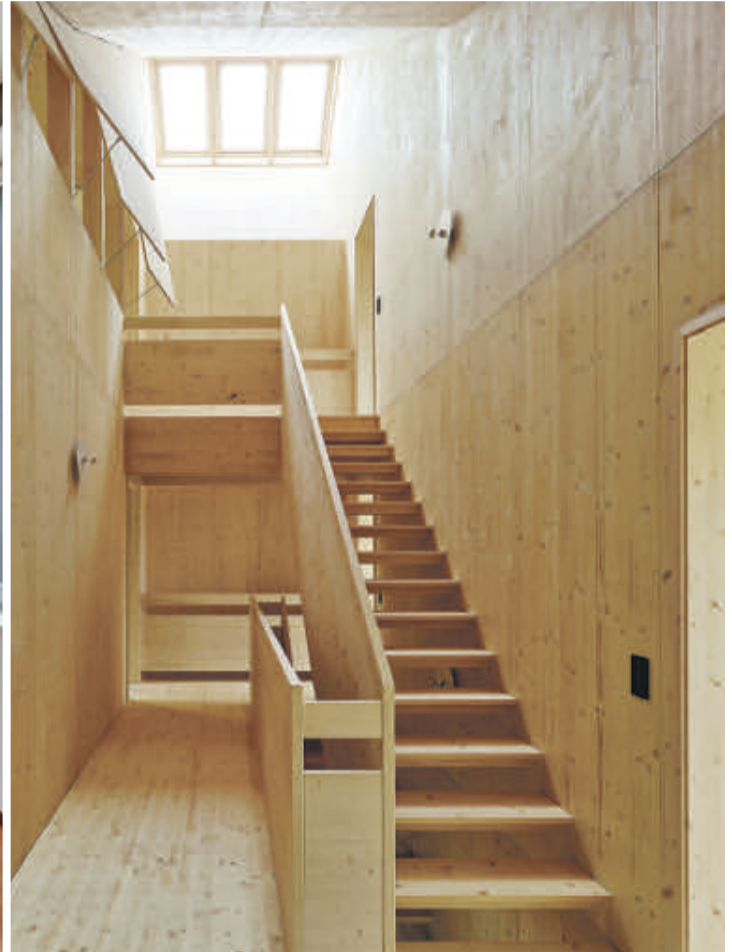
Treppenraum der Haupt- wohnung: Offene Konstruktion aus Balken und Latten
